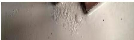
При нанесении состава необходимо следить за временем выработки комплекта и толщиной слоя. Если время выработки одного комплекта будет сильно отличаться от времени выработки следующего или будет большая разница в толщине, возможна визуальная разница и различная степень матового эффекта на стыках рабочих «захваток». Максимальное время выработки комплекта также зависит от температуры и влажности на объекте.
