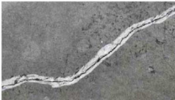
Рисунок 3. V-образная канавка вдоль трещины
