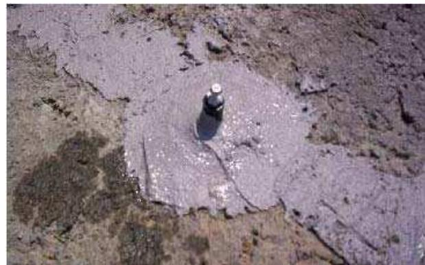
Рисунок 2. Герметизация пакера, установленного на поверхности и трещины при использовании соответствующего средства.
