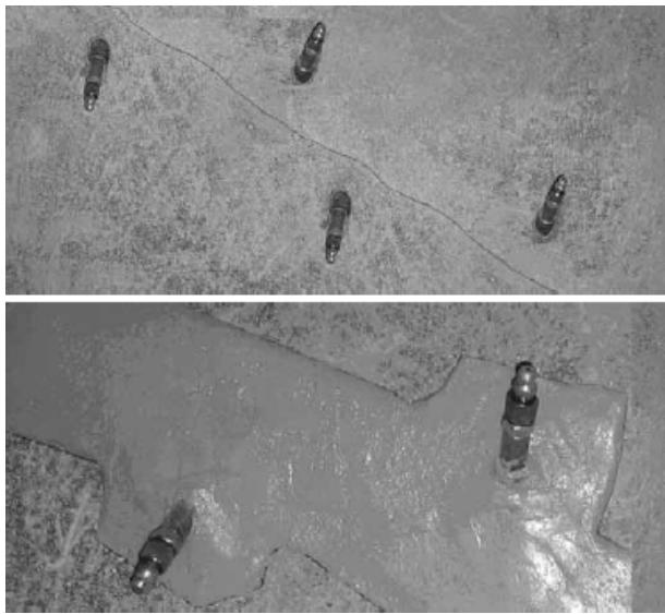
Рисунок 1. Пакеры, установленные вокруг трещины и герметизированные эпоксидным kleем MasterBrace или MasterFlow
