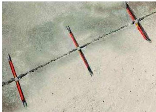
Рисунок 4. Установка стяжек в каналы, открытые в трещинах
