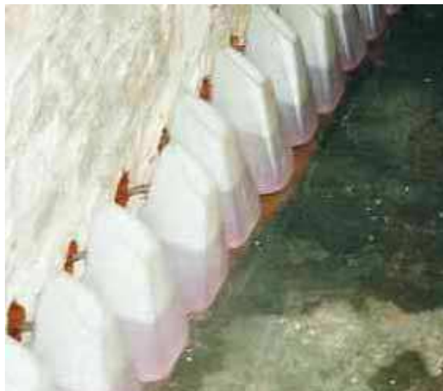
Рисунок 1: Материал PCI Bohrlochsperre в течение не менее 24 часов проникает в кладку из накопительных ёмкостей.
