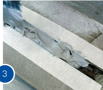
Нанесение адгезива в штрабу.
