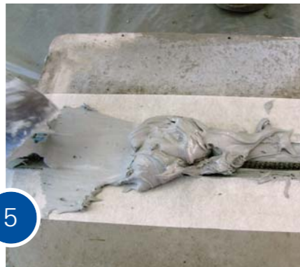
На стержни вновь наносится адгезив и выравнивается поверхность.
