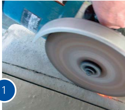
Нарезка штрабы на усиливаемой поверхности.
