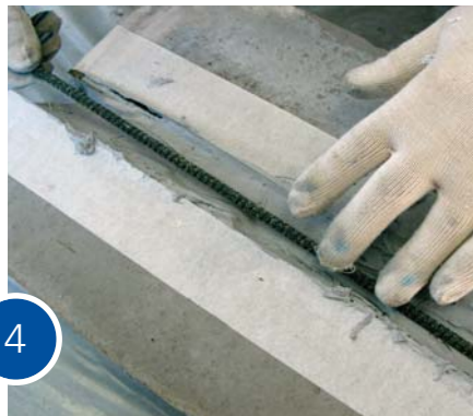
Стержни вдавливанием вкладываются в штрабу.
