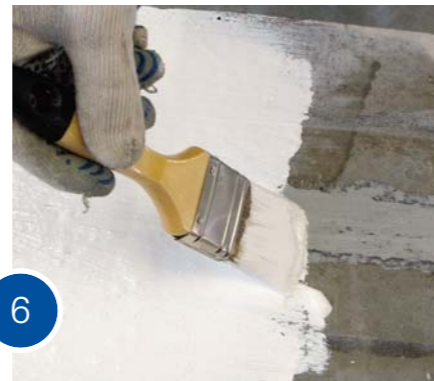
После отверждения наносится финишный слой.
